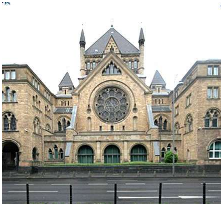
Synagoge in der Roonstraße
